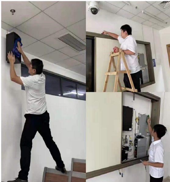
图为维修人员在进行宿舍维修保障工作
