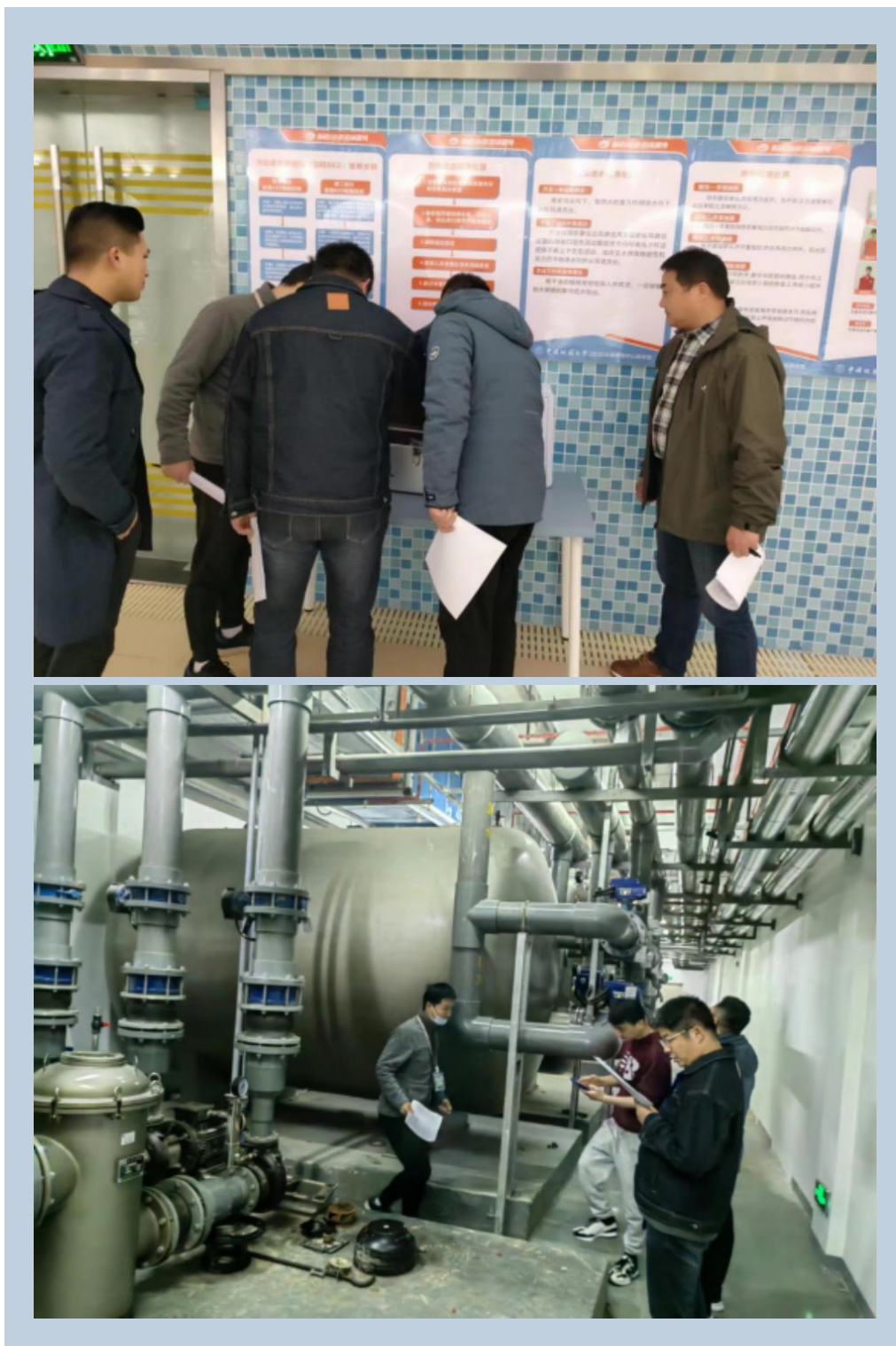
图为检查现场
