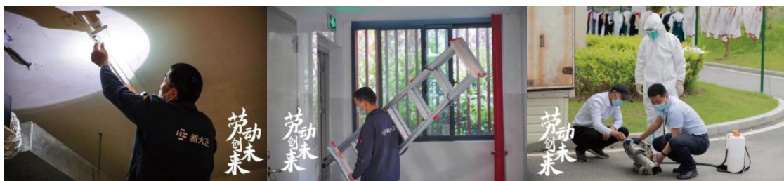
图为维修师傅为校园进行检修
